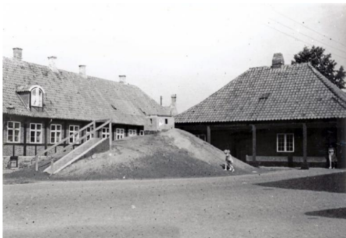
Bunkeren ved Hovedvagten
